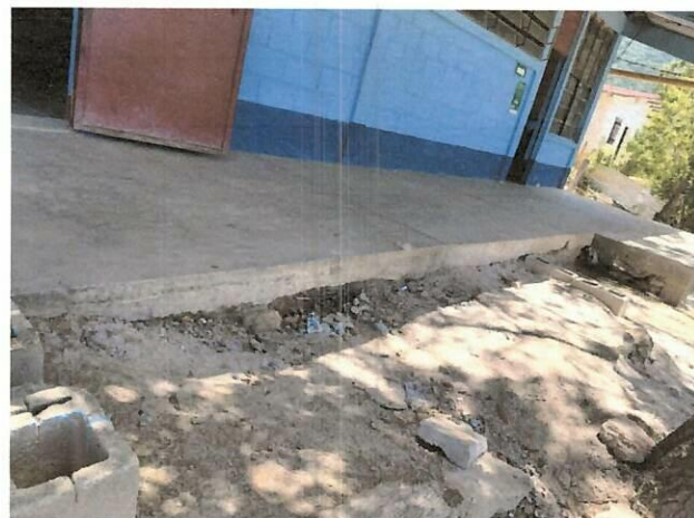
Foto 2: ESTADO ACTUAL DE ÁREA A INTERVENIR LA LOSA DE PATIO
