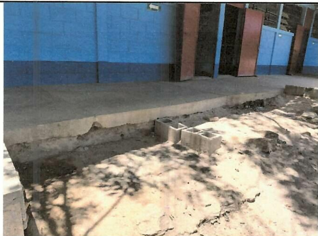
Foto 1: ESTADO ACTUAL DEL ÁREA A INTERVENIR CON LOSA DE PATIO
